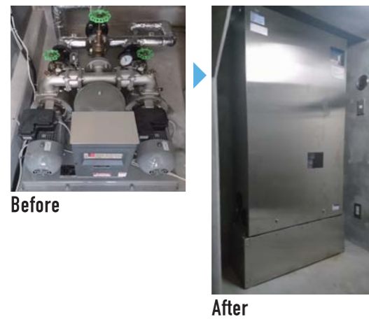
※写真はメカニカルシール部の交換となります。(ポンプ本体からの水漏れを防ぎます。)
