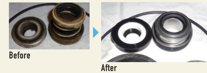
※写真はメカニカルシール部の交換となります。(ポンプ本体からの水漏れを防ぎます。)
